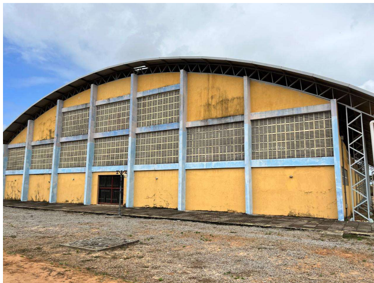
Foto 11 – Imagem externa do ginásio, Fachada frontal.
