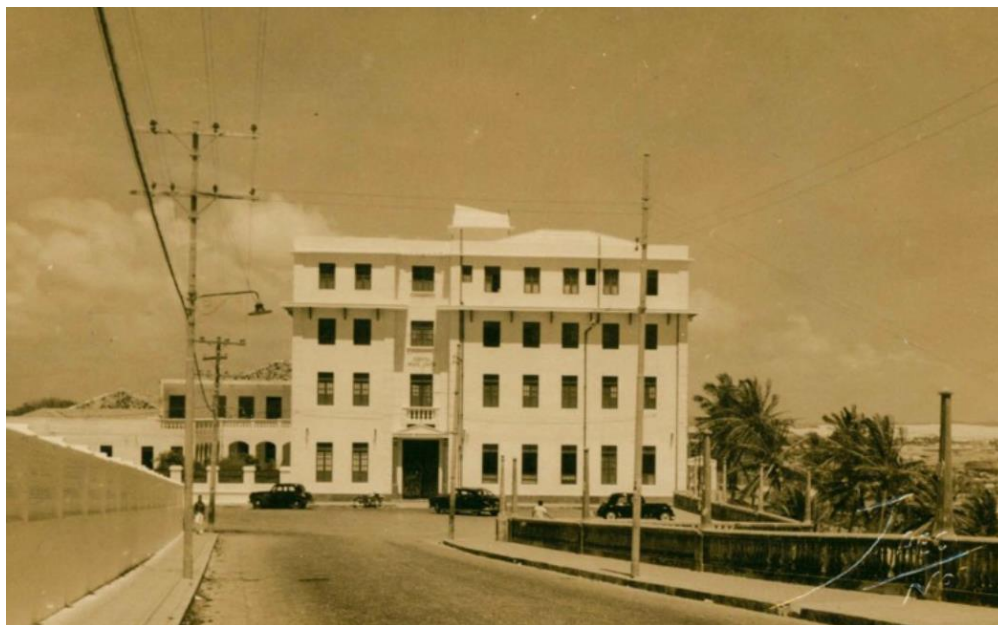
Imagem 2 – Fachada do Hospital Miguel Couto
