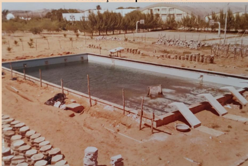
Construção da piscina - 1980
