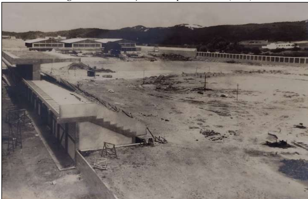
Figura 88 - Construção do campo de futebol (1971)
