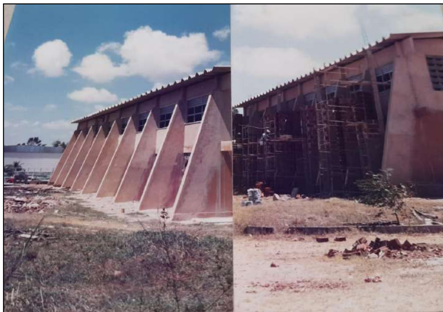
Figura 62 - Construção dos Laboratórios
