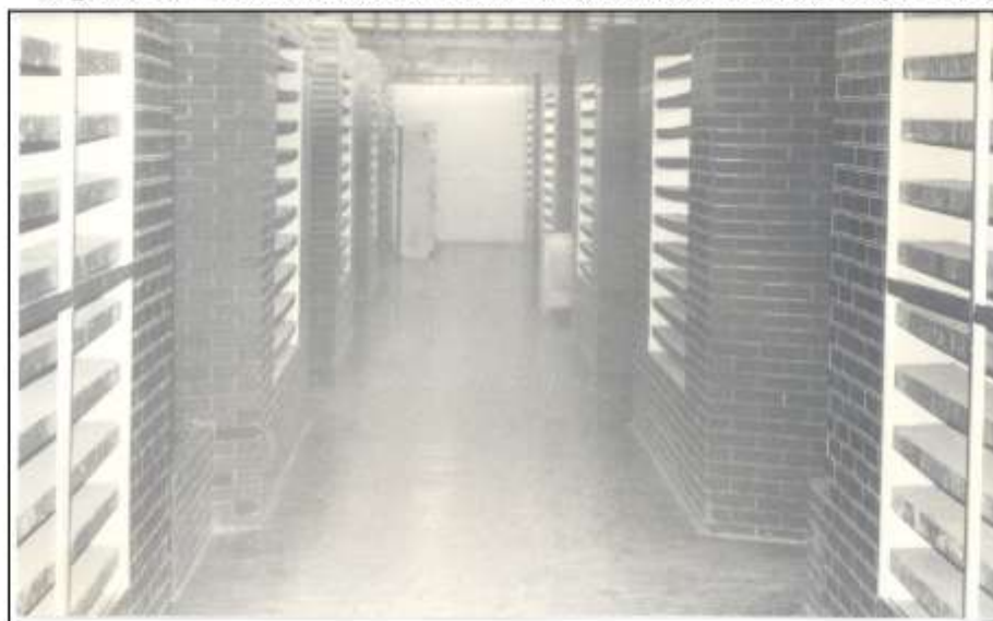
Figura 20 - Reforma nos laboratórios de Eletrotécnica (março/1985)
