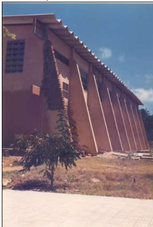
Figura 91 - Construção do Laboratório de Estradas (1988)
