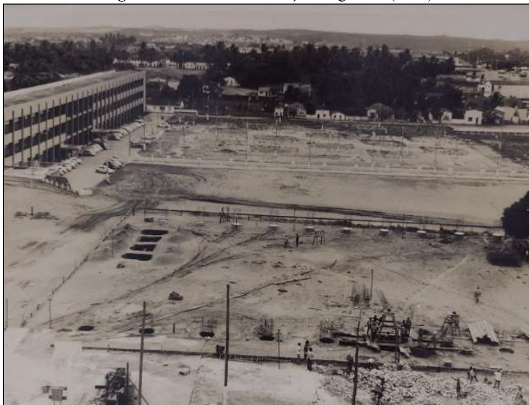
Figura 84 - Início da construção do ginásio (1973)
