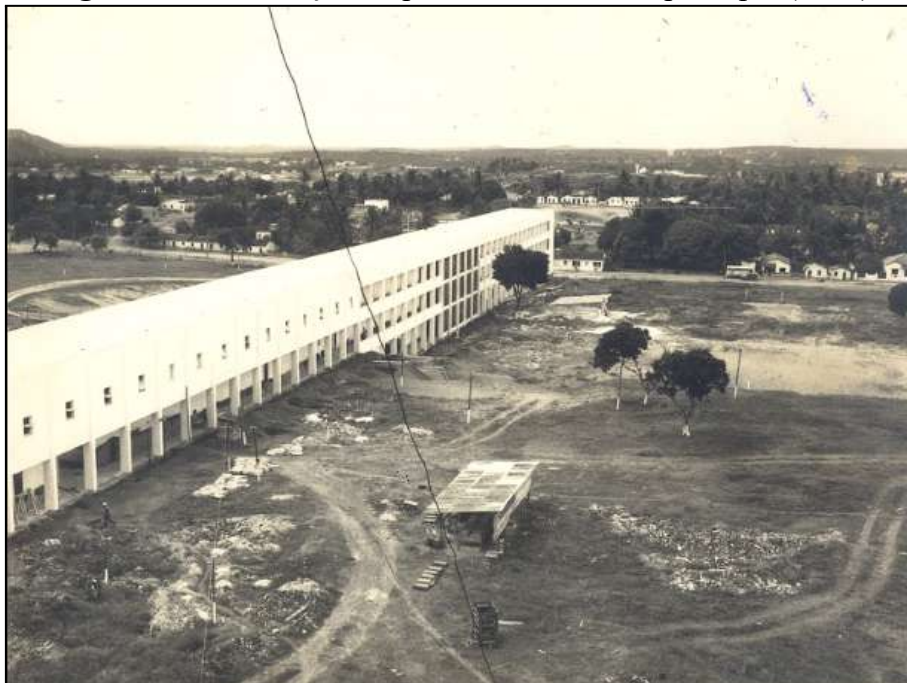
Figura 80 - Construção do pavimento do bloco principal (1966)
