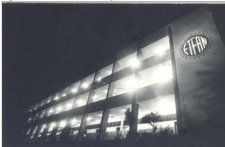
Figura 15 - Fachada da lateral do pavimento de sala de aulas da ETFRN
