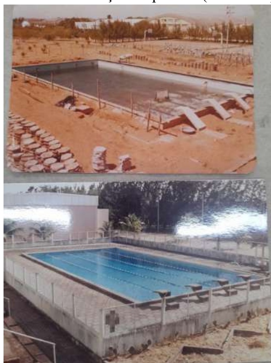
Figura 65 - Construção da piscina (antes e depois)
