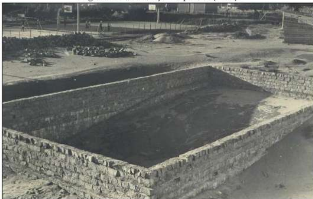
Figura 23 - Construção da piscina (1979)
