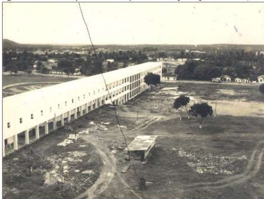
Figura 17 - Finalização da construção do bloco principal de aulas (1966)
