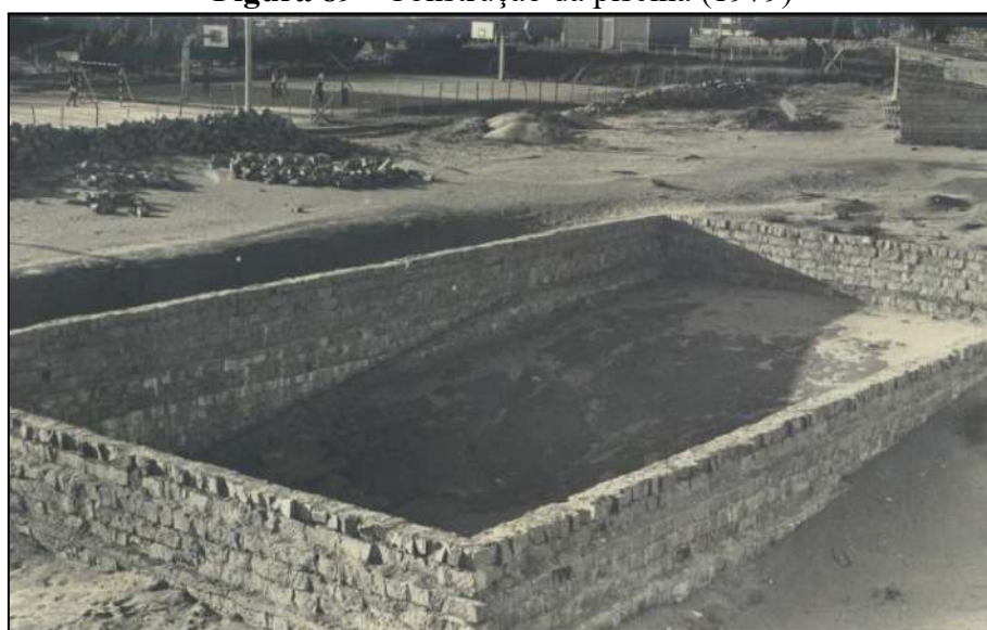
Figura 89 - Construção da piscina (1979)
