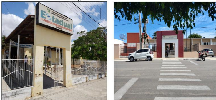
Figura 1: Fachadas da escola.
