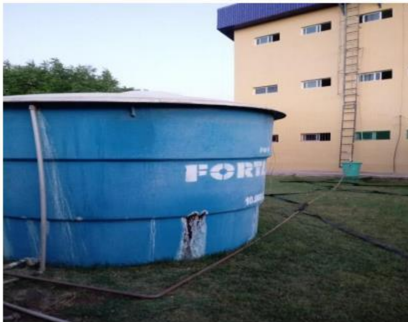
Figura 2: Instalação do carneiro hidráulico
