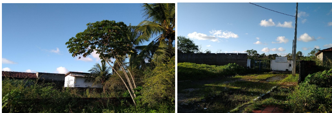
FIGURA 05: CONSTRUÇÃO EM ÁREA DE MANGUE NO CENTRO DE MACAÍBA (RN)
