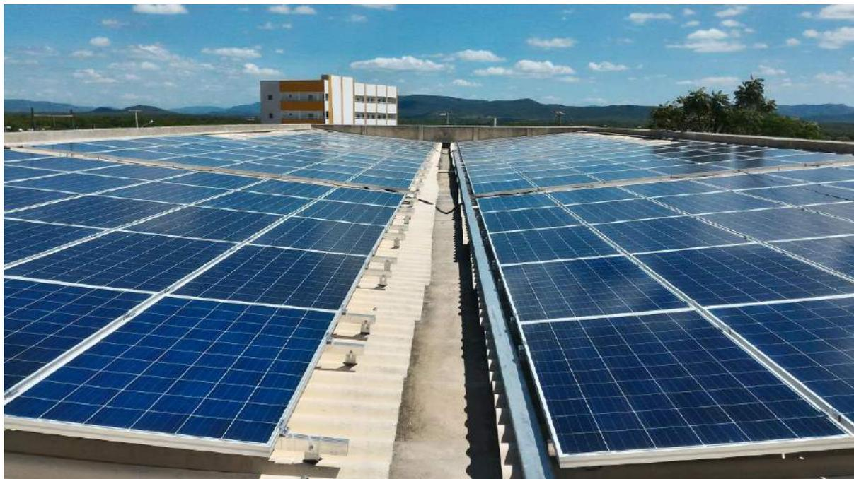
Figura 11 - Estrutura metálica montada sobre o telhado adotada na UFV IFRN – CAMPUS PAU DOS FERROS, na mesma inclinação do mesmo.
